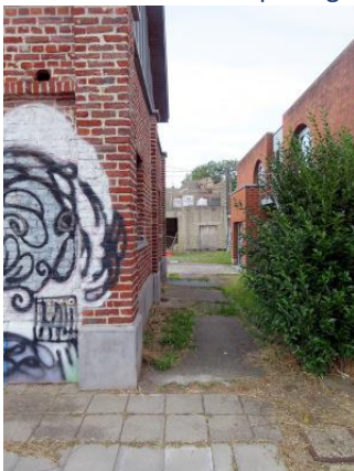
Accès à la voie 1 à gauche du bâtiment
