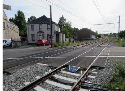
Le revêtement acoustique du passage à niveau
