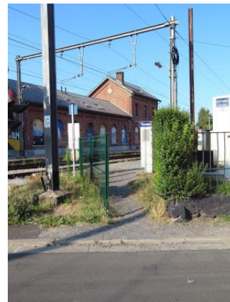
L'unique accès à la voie 2, côté avenue Allende
