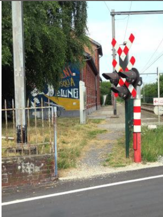
Accès à la voie 1 à hauteur du passage à niveau
