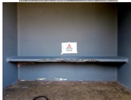
Un des abris de quai venait d'avoir été repeint
