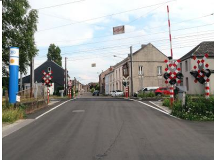
Le passage à niveau n°73, dans l'avenue Allende
