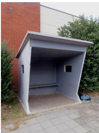
Un des quatre abris en béton avec banc
