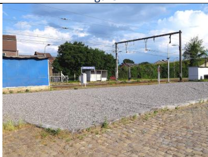
Une étendue de gravier là où se tenait l'ancien bâtiment de gare
