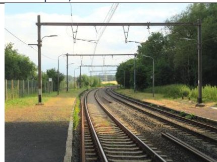
Vue du bout des quais, en direction de Godarville et Manage
