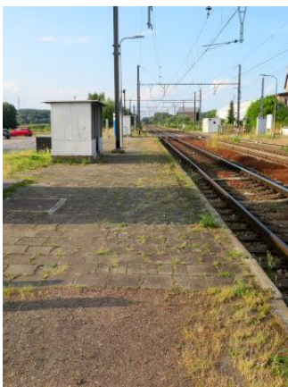
Revêtement : une section en dalles à hauteur de l'emplacement de l'ancien bâtiment de gare, voie 1
