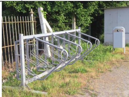
Le râtelier pour vélos se trouve sur le quai, voie 2
