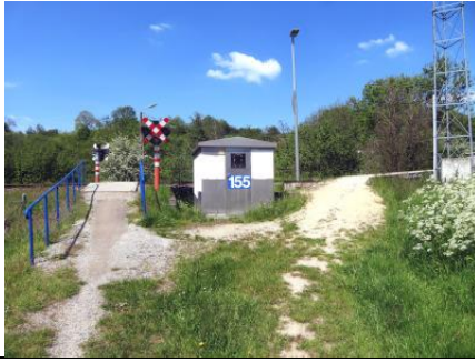
Le passage à niveau est visible à gauche, alors que l'accès au quai est sur la droite
