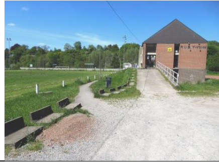
Depuis la rue Fontaine, on accède au point d'arrêt via le sentier sur la gauche, longeant le terrain de foot
