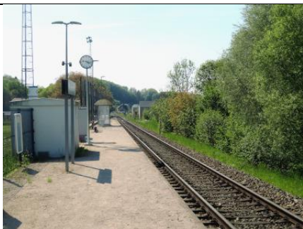
Vue d'ensemble du quai, photographié en direction de Walcourt
