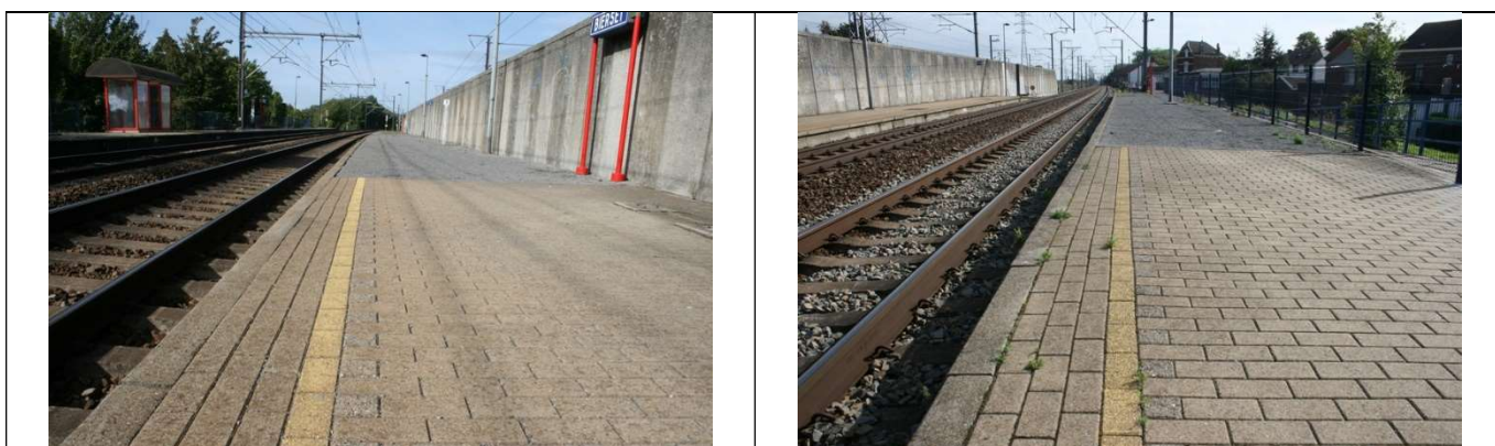
Revêtement des quais
