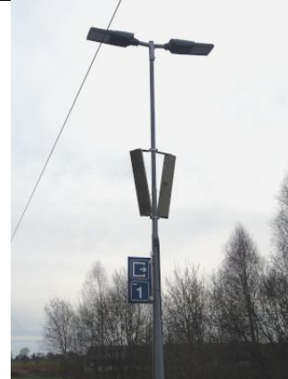
Indicateur de quai et haut-parleur antique sous un éclairage LED à la voie 1
