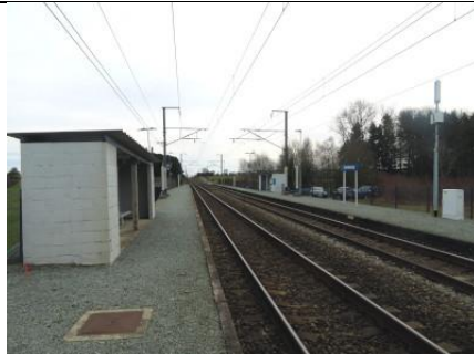
Vue d'ensemble de la voie 2 prise côté Gedinne
