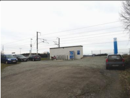
Parking communal ad hoc à hauteur de l'abri de quai de la voie 1
