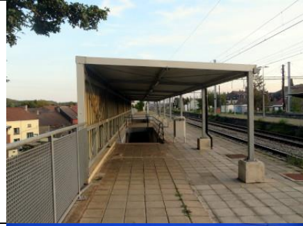
Auvent de la voie 5 sans le moindre siège
