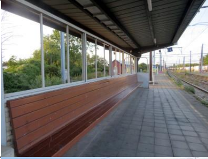
Long banc sous auvent à la voie 2
