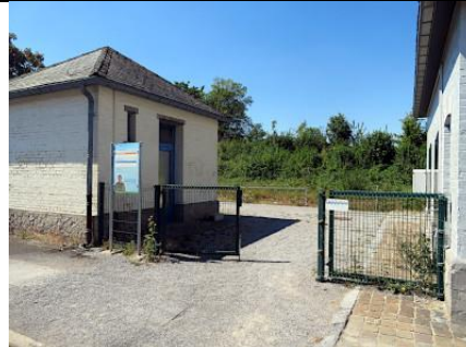
Accès à gauche du bâtiment de gare
