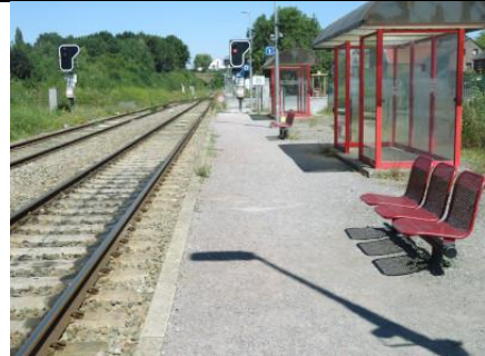
Vue du quai 1 en regardant vers Charleroi
