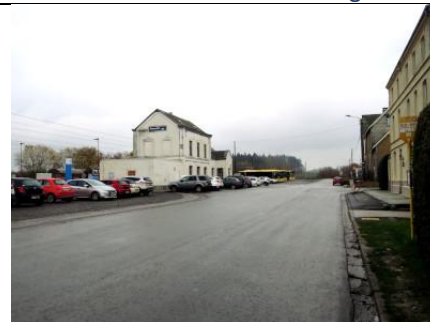
En temps normaux, les voitures stationnent à proximité immédiate du bâtiment de gare
