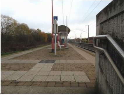
Dalles podotactiles et revêtement des quais
