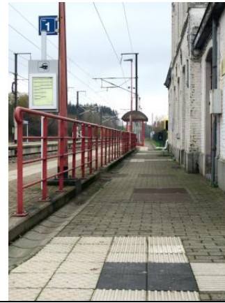
Dalles podotactiles et passage longeant le bâtiment
