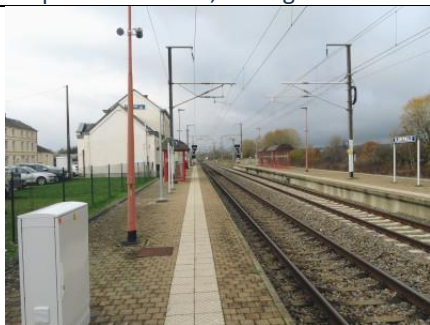
Le quai de la voie 1, le long du bâtiment
