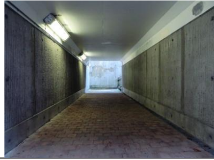
Le couloir sous voies à Florenville
