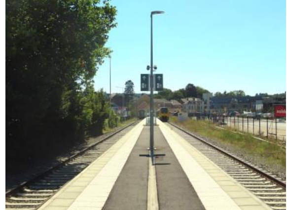
Vue des deux voies, prise côté Mariembourg
